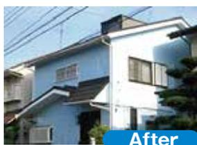
足場・ネット養生・高圧洗浄・下地調整下塗り(微弾性フィラー) シリコン2回塗(合計3回塗)
