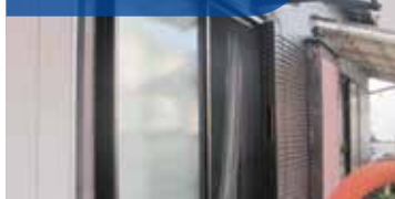
サッシ取り替え(腰窓)
