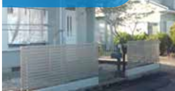
フェンス取り付け
