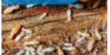
シロアリ工事
