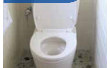
トイレ取り替え
