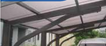
駐車場屋根工事 (ポリカ張り替え)
