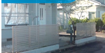
フェンス取り付け
