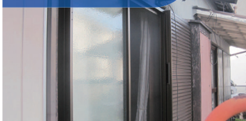
サッシ取り替え(腰窓)
