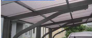
駐車場屋根工事 (ポリカ張り替え)
