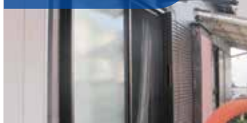
サッシ取り替え(腰窓)
