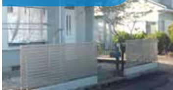
フェンス取り付け
