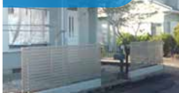
フェンス取り付け
