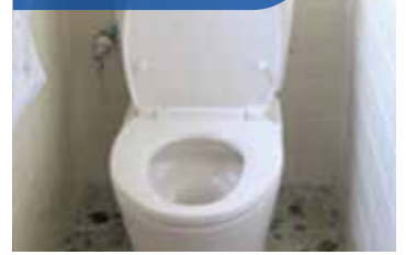
トイレ取り替え
