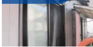
サッシ取り替え(腰窓)
