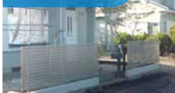
フェンス取り付け
