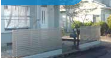
フェンス取り付け
