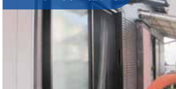
サッシ取り替え(腰窓)
